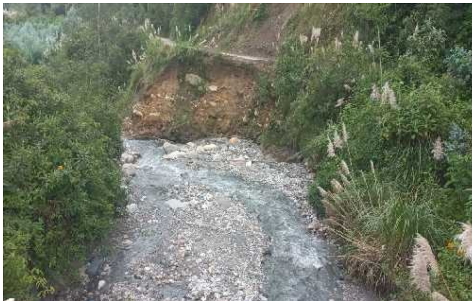
FIGURA N°02: PLATAFORMA DE VIA DE COMUNICACION EXPUESTA ANTE UNA CRECIDA DEL RÍO CHORRO BLANCO EN LA MARGEN DERECHA.
